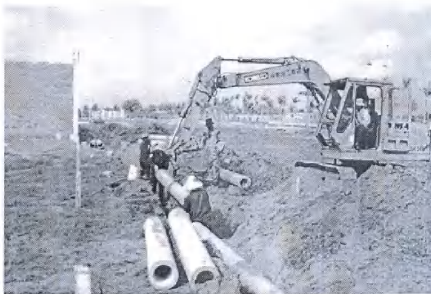
Hình 3: Thi công hệ thống thoát nước của Công ty Cổ phần Cấp thoát nước Cần Thơ
